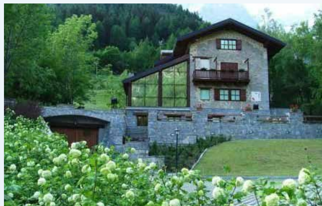
Villa Cameron post ristrutturazione - Credits FMS
